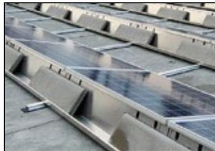
mit der Firma 10hoch4 200 Module mit einer Leistung von insgesamt 50 kWp verbaut.
